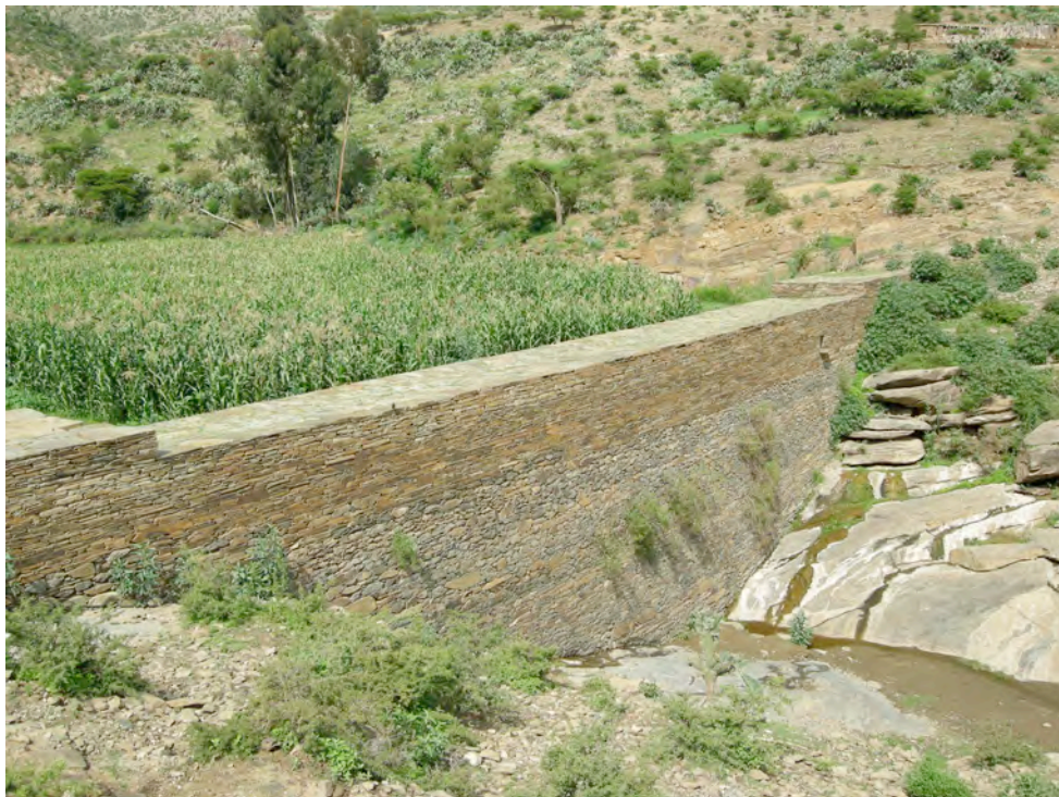
Alahkolo Staumauer (Check dam) in Awo mit Maisfeld, erbaut 1976
