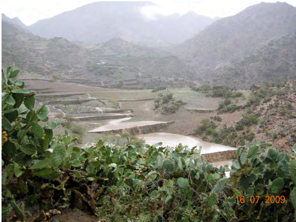
Stufenterrassen (Check dams) mit Flutbewässerung während Regenschauer
